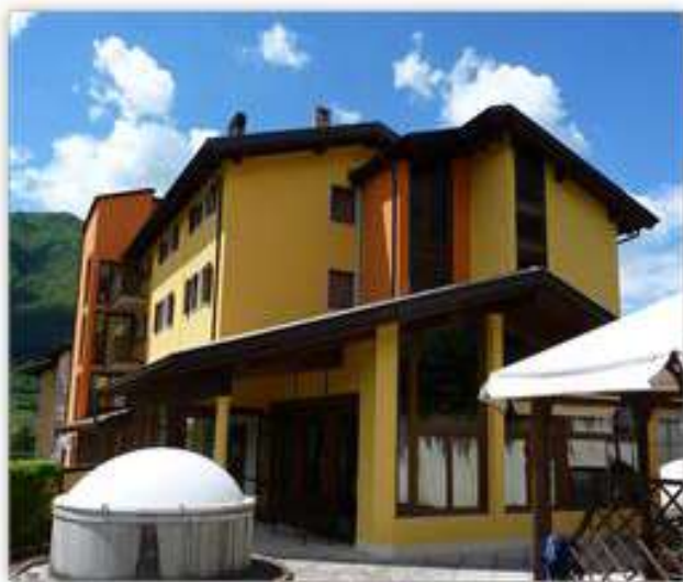
Vista della struttura dall'esterno della sala fisioterapia - piano terra.
